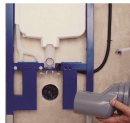
Proceso de instalación (ejemplo en Duofix Sigma 8 cm)
