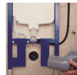
Proceso de instalación (ejemplo en Duofix Sigma 8 cm)
