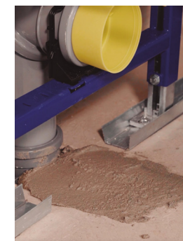
Relleno de mortero
